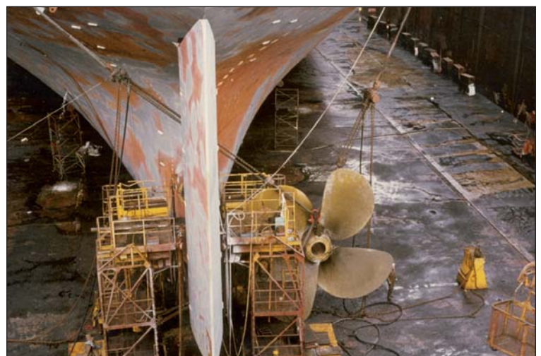
Konzentrierte Kraft mit feinfühligter Steuerung. Die Demontage des Propellers erfolgte mit mehreren JDN-Druckluft-Hebezügen PROFI 50 TI.
