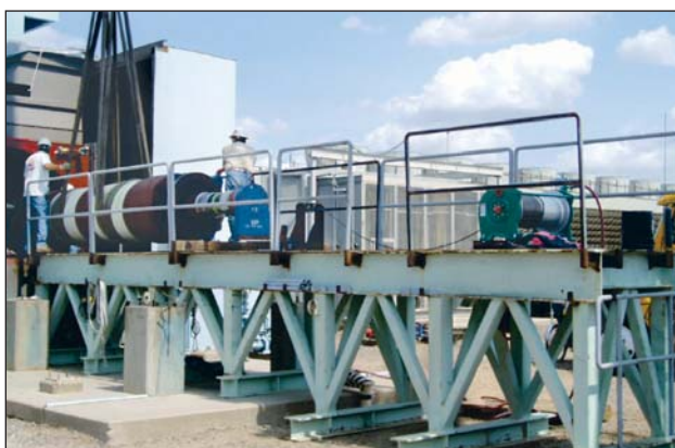
Mit Hilfe einer JDN-Druckluft-Winde PROFILIFTER wird ein tonnenschwerer Rotor aus der Transportverpackung gezogen.
