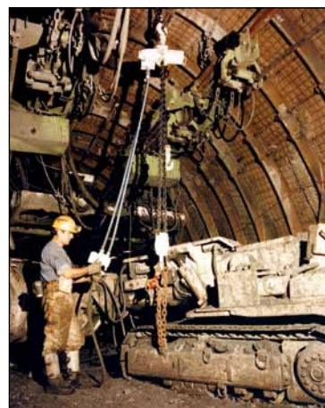
Пневматический подъемник JDN M63D, поднимающий застрявший погрузчик.
