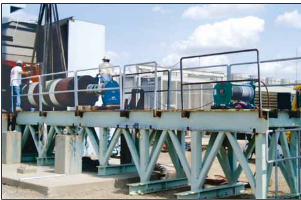
Транспортировка ротора с помощью пневматической лебедки JDN PROFI PULLER.
