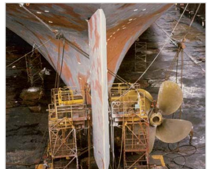
Demontage einer Schiffsschraube mit mehreren JDN-Druckluft-Hebezügen PROFIL 50 TI.
