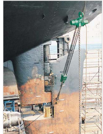
Rudermontage mit zwei JDN-Druckluft-Hebezügen PROFIL 100 TI.
